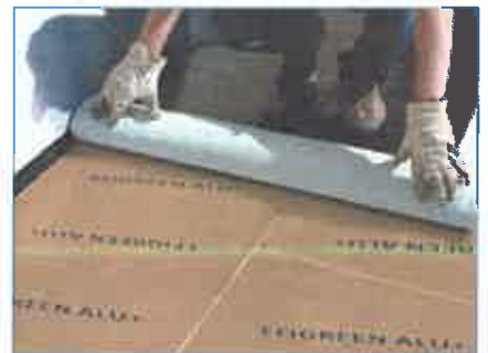
2 Positionner le rouleau Soprastick® SI (ou Soprastick SI4), puis l'enrouler sur la moitié de sa longueur.
