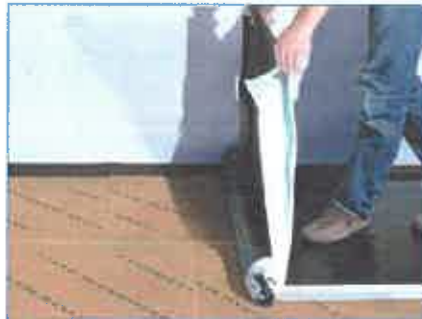
4 Décoller le film et faire adhérer la partie sur l'isolant.
