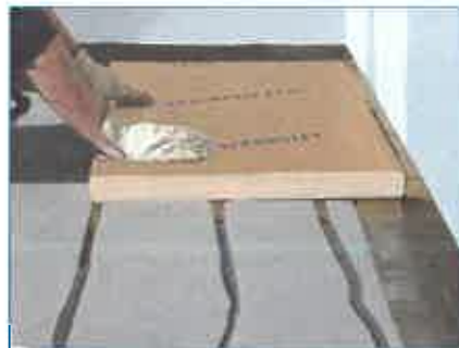
1 Sur le pare-vapeur, appliquer les panneaux d'isolants par légère pression sur la colle type Coltack®.
