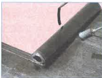
7 Pose de la deuxième couche Elastophène® Flam 25 AR . La deuxième couche autoprotégée est soudée en plein à joints décalés, ou croisés. Les recouvrements sont de 6 cm soudés.
