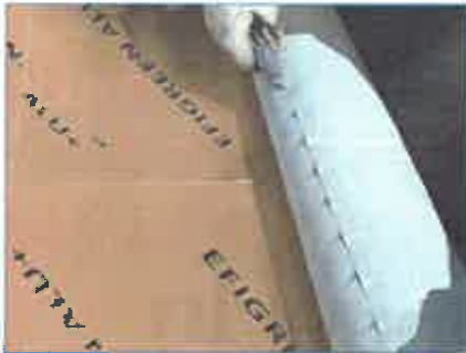
3 Découper le film siliconé en sous face à l'aide d'un cutter. Procéder délicatement afin de ne pas couper la membrane.
