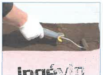
8 Relevé d'étanchéité réalisé sans flamme en Alsinger® ingévat SAS au Capital de 147 000 € 120 rue du Thor - Blue D'oc 34000 MONTPELLIER RCS Montpellier 430 026 932 Tél. : 04 67 59 09 08
